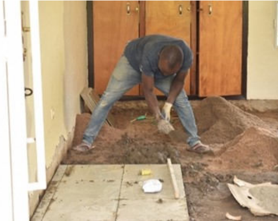
Réhabilitation des locaux du centre
