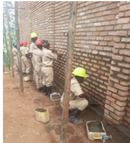
Jeunes en formation maçonnerie dans leur milieu de stage
