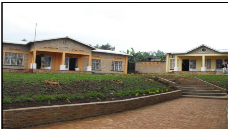
Les batiments du Centre de formation professionnelle de l'OPDE Rwanda
