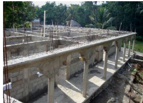
Maison Partage du Savoir en construction.
