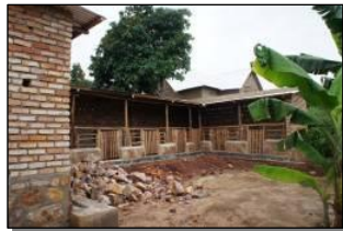
Construction de la porcherie
